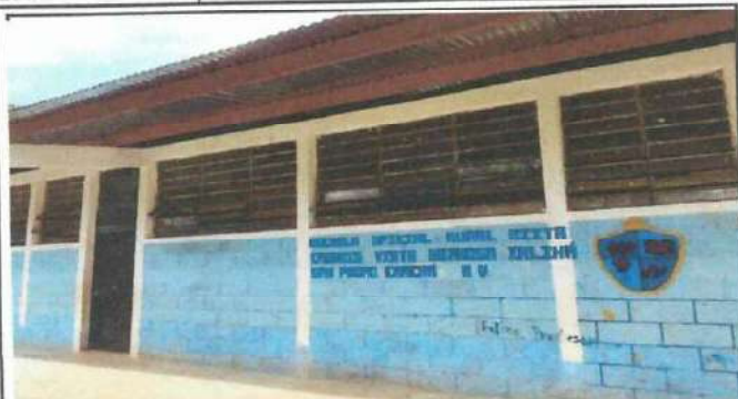
Foto1: MANTENIMIENTO DE COSTANERAS DE AULAS
