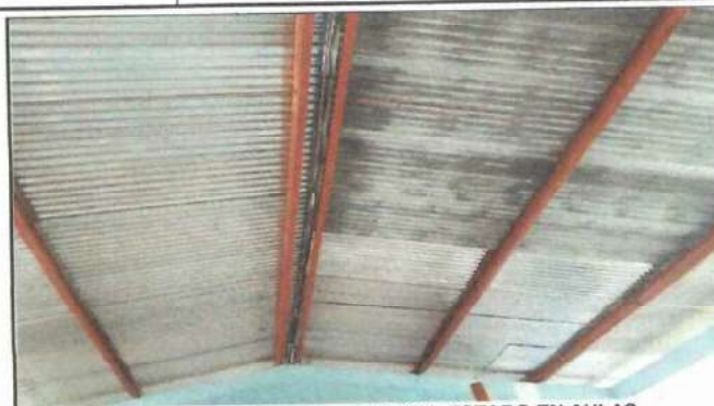
Foto 2: SUSTITUCION DE LAMINAS EN MAL ESTADO EN AULAS
