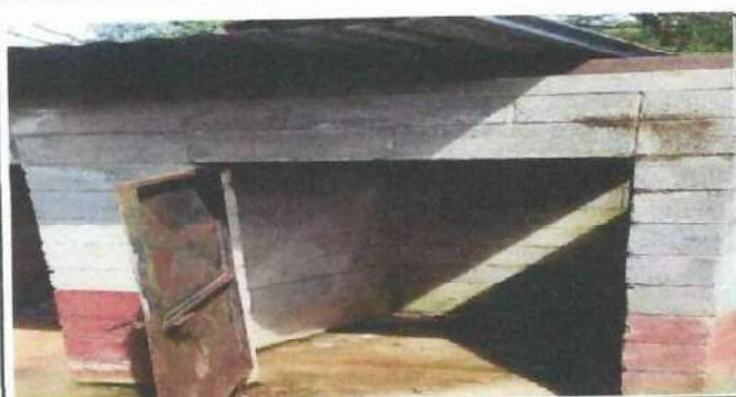
Foto 5: SUSTITUCION DE LETRINAS EN MAL ESTADO
