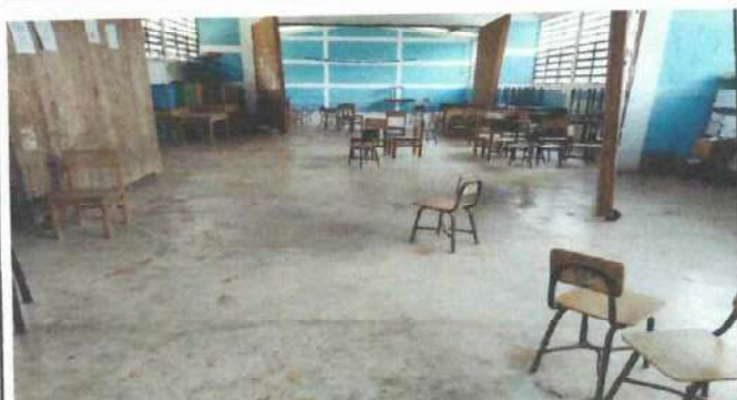
Foto 3: SUSTITUCION DE PISO EN MAL ESTADO POR PISO CERAMICO
